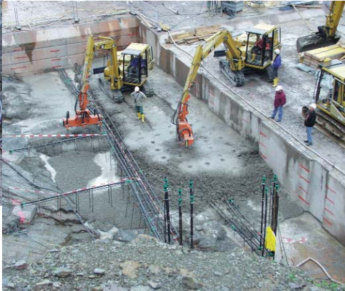
Pelleteuse équipée de vibrateurs pneumatiques internes de la série NHR pour le compactage de béton de masse
