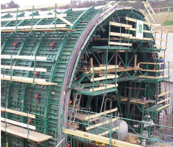
Oszalowanie tunelu z wibratorami pneumatycznymi, przyczepnymi z serii NVT
