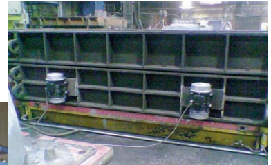
Zagęszczanie betonu w formie stalowej, za pomocą wibratorów elektrycznych, przyczepnych z serii NEG
