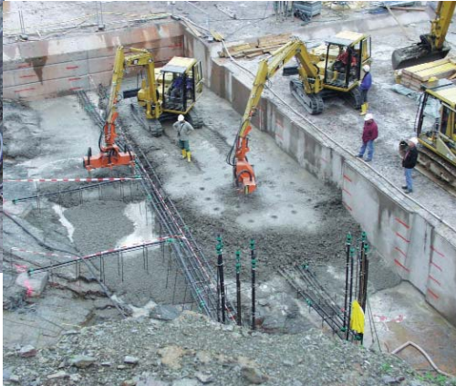
Koparka wyposażona w wibratory hydrauliczne, pogrążalne z serii NHR, przeznaczone do zagęszczania betonu
