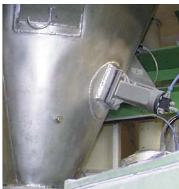
Очистка стенки бункера
