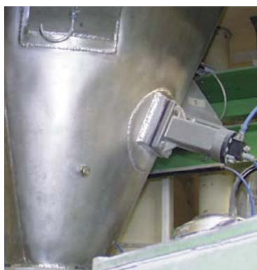
Czyszczenie ścianki zbiornika
