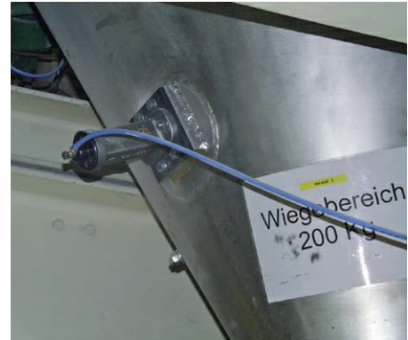
Décolmatage de réservoirs de pesage
