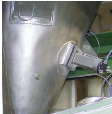
Paredes de depósitos
