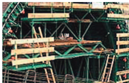
Vibración de encofrados
