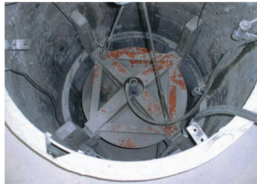
Compactación de revestimiento refractario en hornos
