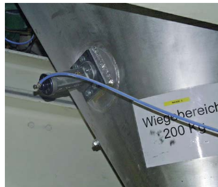
Czyszczenie zasobnika wagowego
