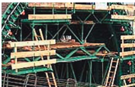
Oszalowanie tunelu
