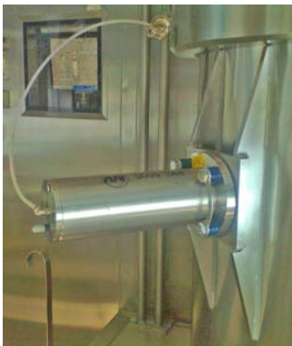
Nettoyage de conduites
