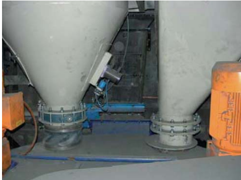
Décollement d'incrustations tenaces à l'aide de vibrateurs pneumatiques à piston
