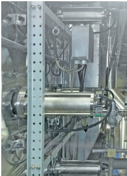
Décolmatage des échangeurs de chaleur (à droite : NHK avec capot antibruit)
