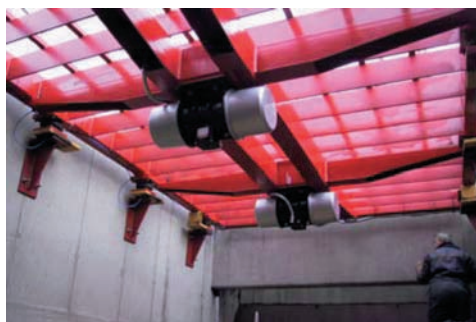
Eliminación de impuros y tamizado de material grueso utilizando vibradores eléctricos
