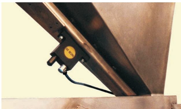
Vaciado de tolvas
