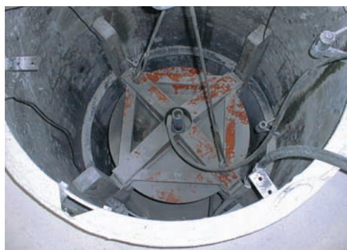
Compactación de revestimiento refractario en hornos
