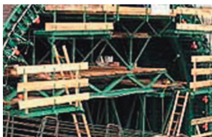
Vibración de encofrados
