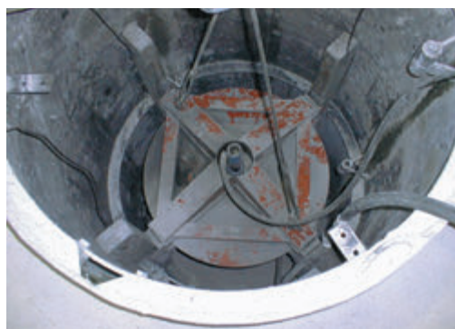
Ofenzustellung mit NKH
