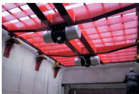
Przesiewanie materiałów gruboziarnistych za pomocą elektrycznych wibratorów przyczepnych
