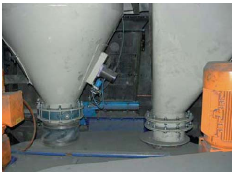
Usuwanie twardych oklejeń za pomocą pneumatycznych wibratorów tłokowych
