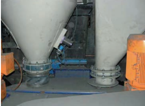
Eliminación de costras de material mediante vibradores neumáticos lineales
