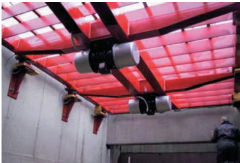
Eliminación de impropios y tamizado de material grueso utilizando vibradores eléctricos
