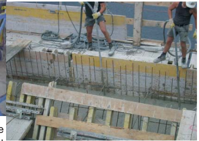
Compactage de béton dans la construction de bâtiments avec vibrateurs électriques internes de la série NCZ
