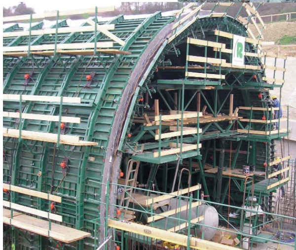
Опалубка туннеля с прицепными пневматическими вибраторами серии NVT.
