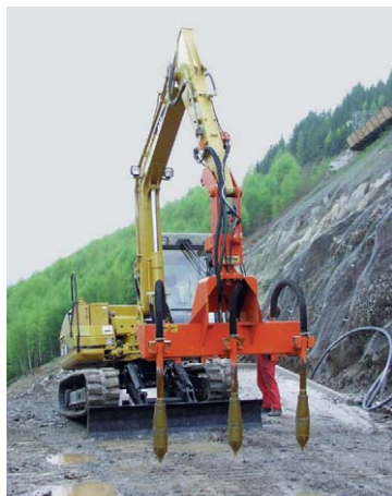
Экскаватор оснащенный погружными, гидравлическими вибраторами серии NHR, предназначенными, для загущения бетона.
