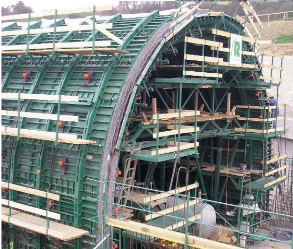
Coffrage de tunnel avec vibrateurs pneumatiques externes de la série NVT
