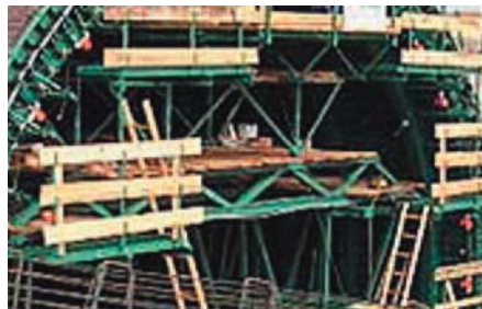
Coffrage de tunnel
