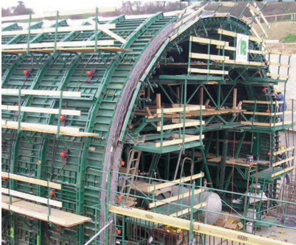
Tunnelschalung mit Druckluft-Außenvibratoren Serie NVT
