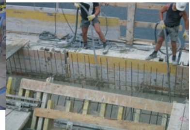
Betonverdichtung im Hochbau mit Elektro-Innenvibratoren Serie NCZ
